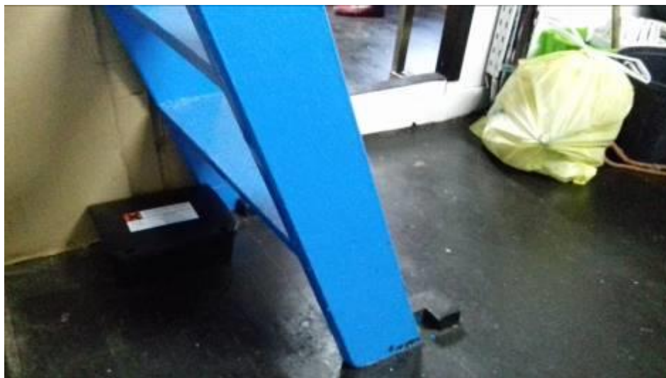
Figura 4 _Caixa rateira instalada na cozinha da embarcação Cabo Avelar Pessoa
