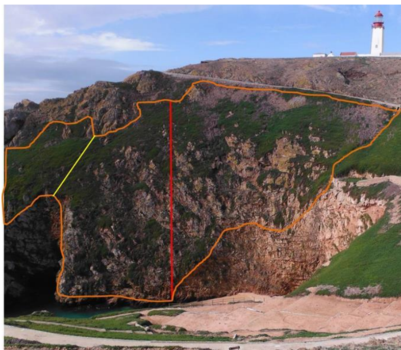
Figura 17 _Delimitação das áreas de intervenção na vertente Oeste do Carreiro do Mosteiro.
